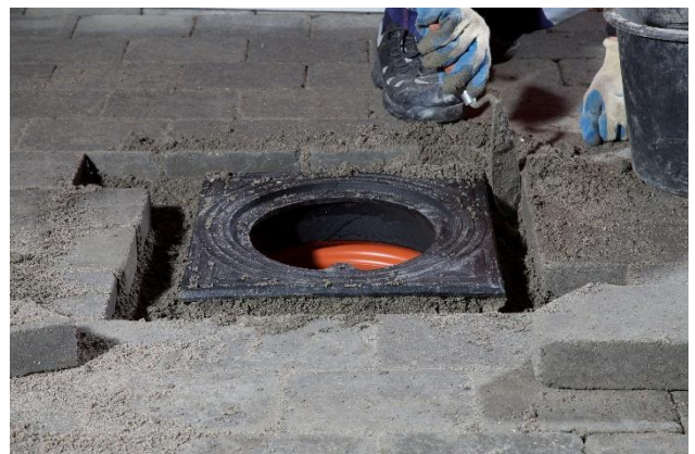
Den overskydende beton fjernes.
