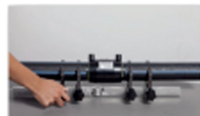
Monter holdeværktøj og tilret rør og fittings.
