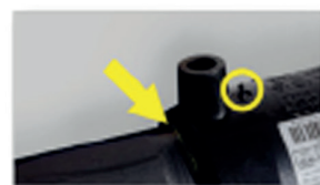
Start svejsning. Udfør de krævede kontrolleringer (tilretning, indføringsdybde og svejseindikatorer).
