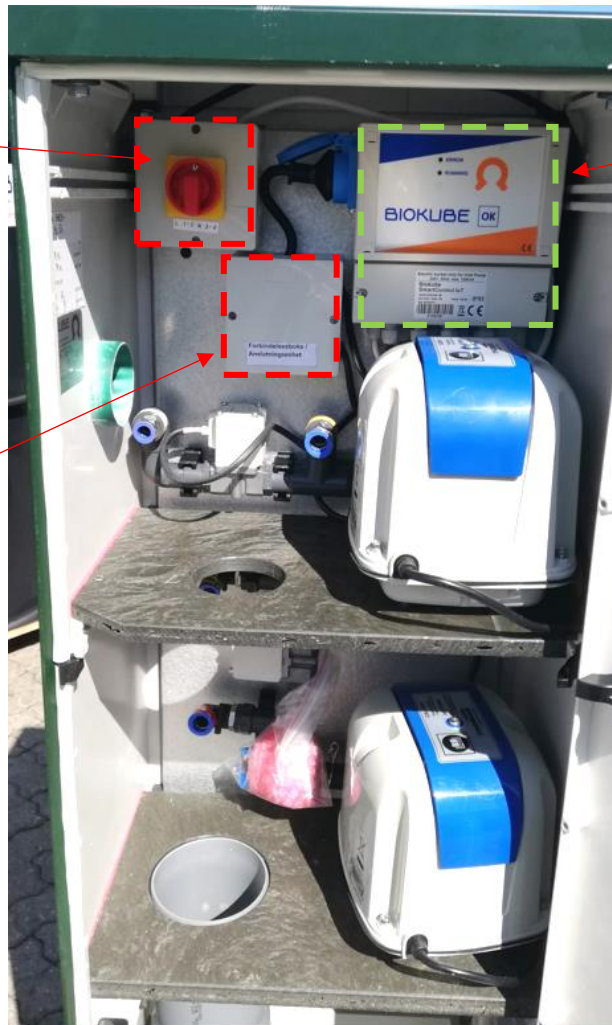
El- og kabeltilslutningspunkter i det eksterne teknikskab
