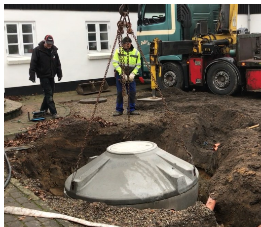
En BioKube beton SPE bliver installeret
